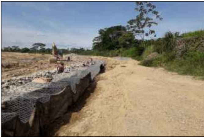
15/06/2021.- Inspección al proyecto construcción de muros defensivos en el río Ivirgarzama del Distrito-VI, con el fin de evitar pérdidas por desastres naturales y resguardar la planta de tratamiento de aguas residuales.
