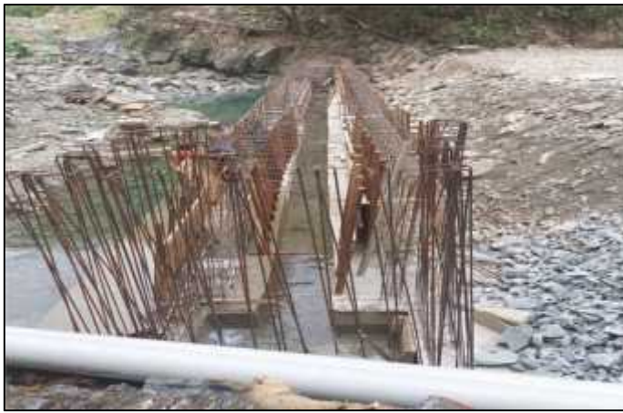
19/05/2021.- Inspección a la obra en construcción de la galería filtrante para la captación mayor del agua, en la toma de agua Puerto Rico.
