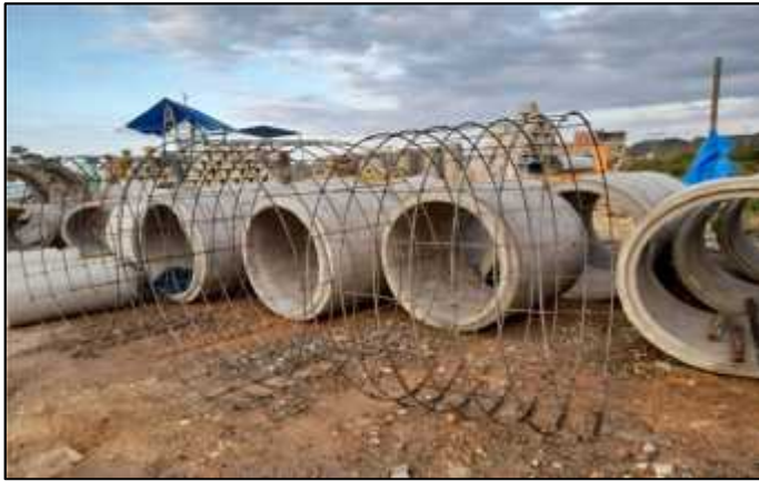
25/06/2021.- Se realizó entrega de recepción de provisión de 12 tubos de H°A D=1000MM para la construcción de Alcantarillado en el Distrito VI.
